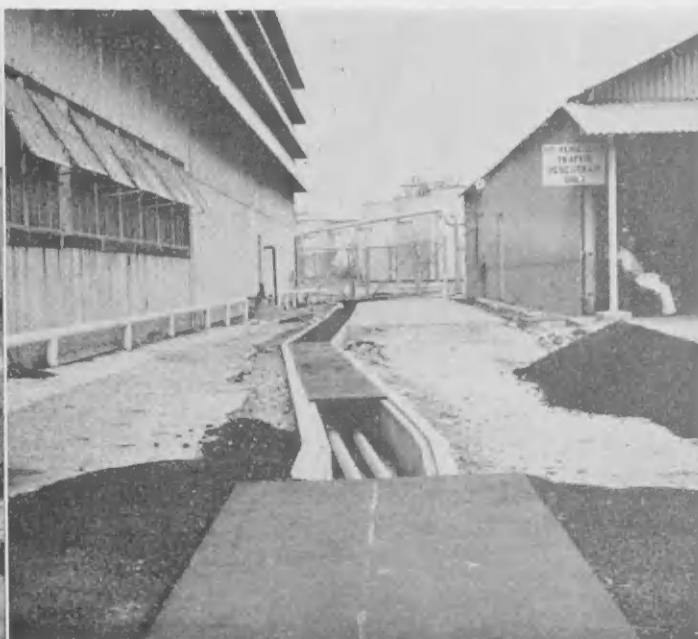
TUR DOS tanki y linja a worde trahá y instalá pa Ethyl door di Curaçaoche Dokmaatschappij y sub-contratistanan. Maske e compuesto di chumbo ta casi dos vez mas pisá cu awa, linja regular di tres duim ta hiba e compuesto pa tanki.
